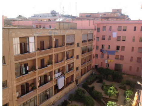
Foto 3 - Vista dall'alto di un edificio
