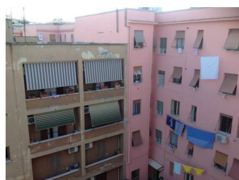
Foto 4 - Vista del giunto tra edifici
