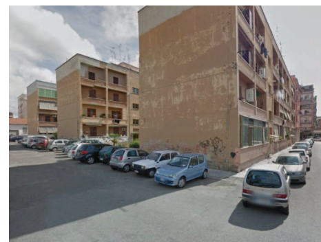
Foto 9 - Vista dei tre edifici da demolire
