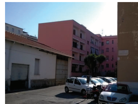
Foto 8 - Vista della parte di edificio su cui non si interviene
