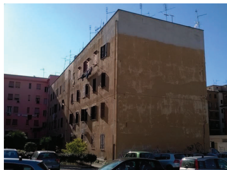
Foto 5 - Vista del fronte cieco di un edificio
